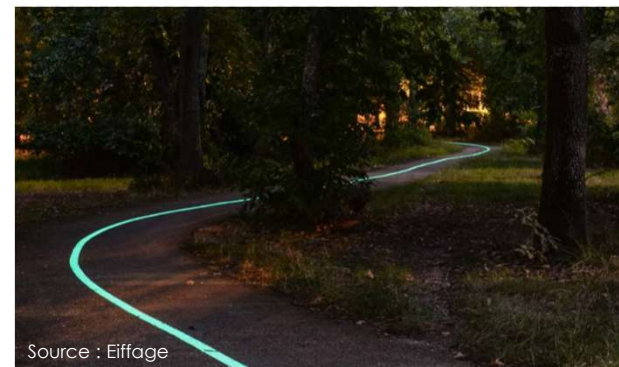
Voirie lumineuse (Eiffage luminochrome)
